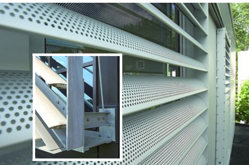
Architecturale zonweringsystemen met aluminium lamellen vragen een duidelijke studie van de belasting op de gevel, vaak zijn verstevigende elementen vereist
